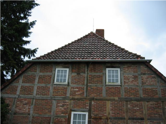
Abbildung: Die neue Dachrinne
