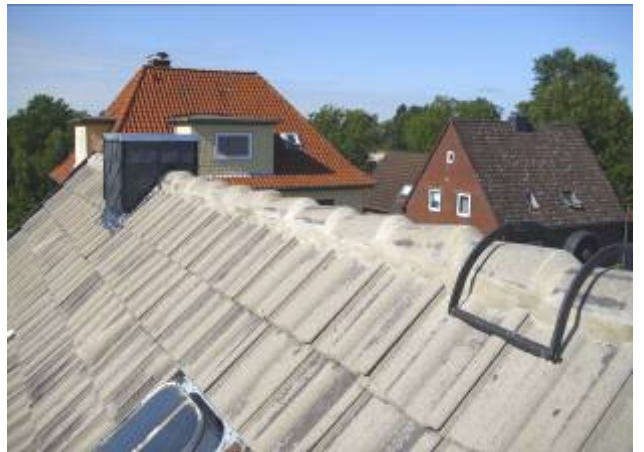
Überprüfung aller Dachbereiche und Anschlusspunkte (Hier: Mörtelfirstsanierung) Vor der Sanierung
