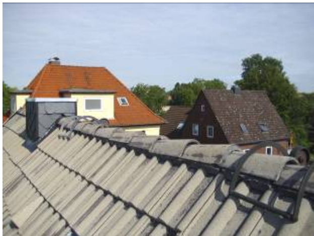
Überprüfung aller Dachbereiche und Anschlusspunkte (Hier: Mörtelfirstsanierung) Vor der Sanierung
