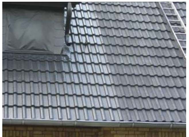
Grundierung und Endbeschichtung der Dachfläche in zwei Arbeitsgängen Auftrag der Grundierung
